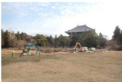
講堂・三面僧坊跡地区（令和3年12月16日現在）
